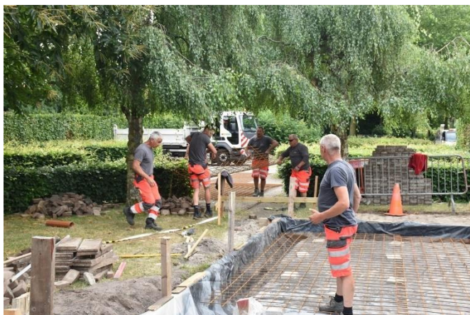
Plaatsen van de vloerplaat door de technische dienst van de gemeente Zoersel voor de bouw van de "Smidse Bogaerts" achter het heemhuisje.
